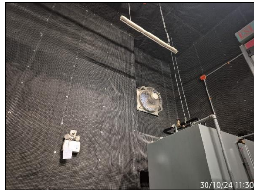
ภาพที่ 68 พัฒนาระบายอากาศในห้องเครื่องกำเนิดไฟฟ้า
