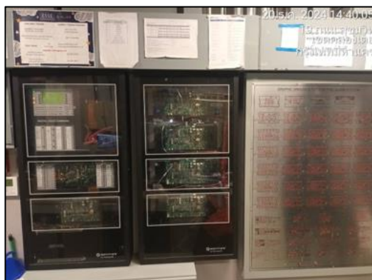
ภาพที่ 38 แผงควบคุมระบบอัคคีภัย
